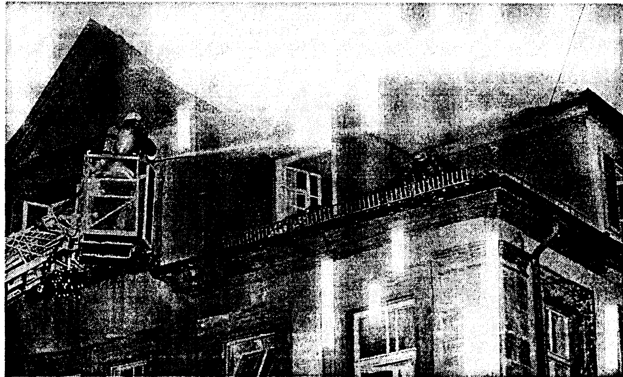
Von Drehleitern aus bekämpften die Feuerwehrleute den Brand im Eckgebäude Martin-Luther-Platz/Pfarrstraße von außen, konnten aber nicht verhindern, dass die Flammen schließlich doch durch den Dachstuhl durchschlugen. Fotos: Pfrogner
